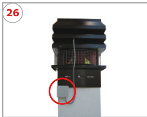
26 Posición correcta de la caja de derivación.
