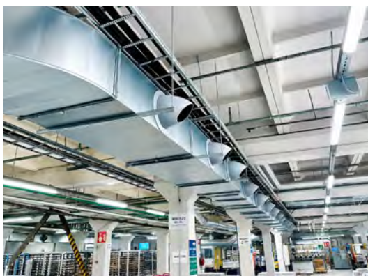
Toberas de alta inducción integradas en conducto rectangular
