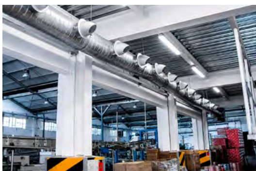
Toberas de alta inducción integradas en conducto circular
