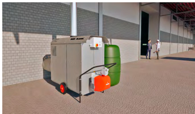
Instalación de un equipo AM con conducto en una nave industrial. Installation of a ducted AM equipment in an industrial building. Installation d'un équipement AM gainable dans un bâtiment industriel.
