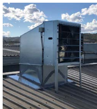
Instalación en tejado Roof installation Installation du toit
