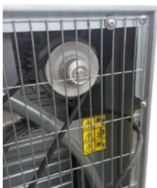
Motor a transmisión con base tensora
